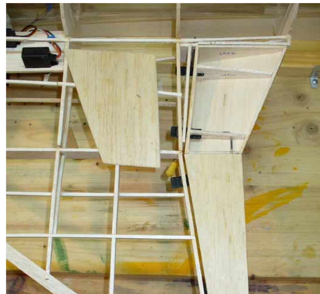
Erst nach dem Einbau der Ruderhälften erfolgt das Beplanken der Oberseite. Dies erleichtert das Einfädeln des Ruders in das Anlenkungsgestänge erheblich.
