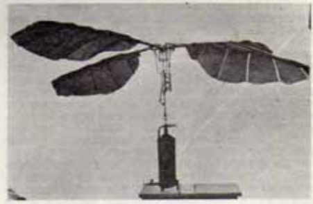
Der Schrauben-Schwingenflieger von Chalupsky. Modell 2.
